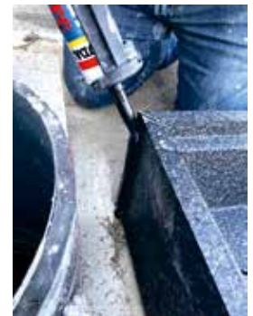
5. Gehrungen und Schrauben mit Montagekleber verschließen
