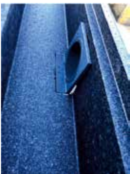
6. Abläufe und Blech montieren
