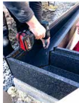
4. Steine und Betonkrone befestigen
