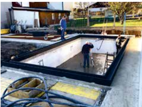
3. Mit Stellfüßen nivellieren und ausrichten
